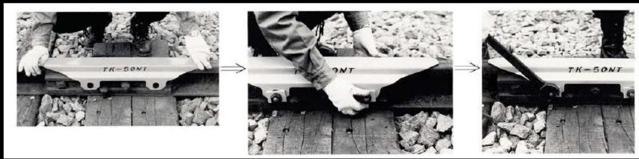
レールき損対策用 軽量・簡単装着・確実な緊締 応急処置器！！
